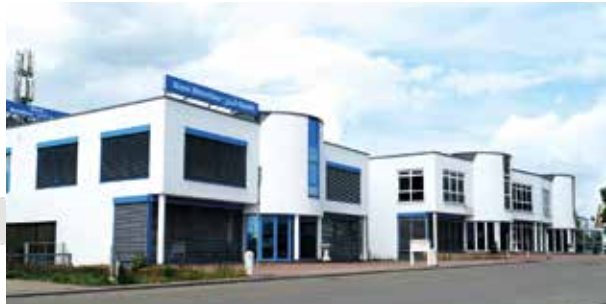
Produktionsstandort I, Max-Eyth-Str. 7-9 Verwaltung, Konstruktion/Entwicklung, Projekt Vormontage, Lackierung, Stahlfertigung I, Kunststoffe
